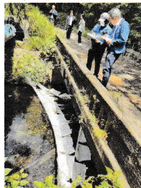
5月の燃料油流出では、蓼川の立川橋にオイルフェンスが張られました
